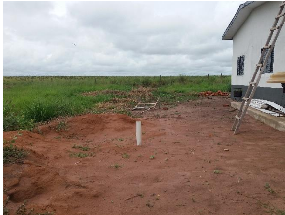
Figura 3. Vista da fossa negra instalada na comunidade
