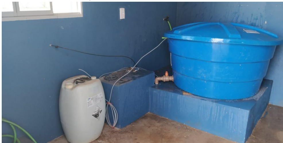
Figura 7. Tratamento com Cloro PT-05
