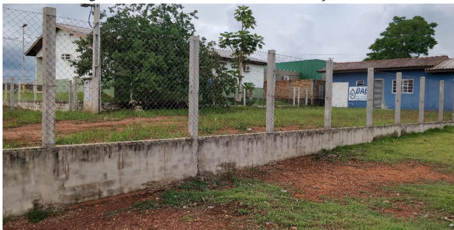
Figura 10. Cerca e Mureta da área do Poço Existente
