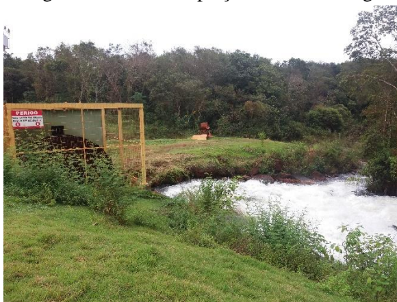
Figura 2. Vista da Captação no Rio Formiga
