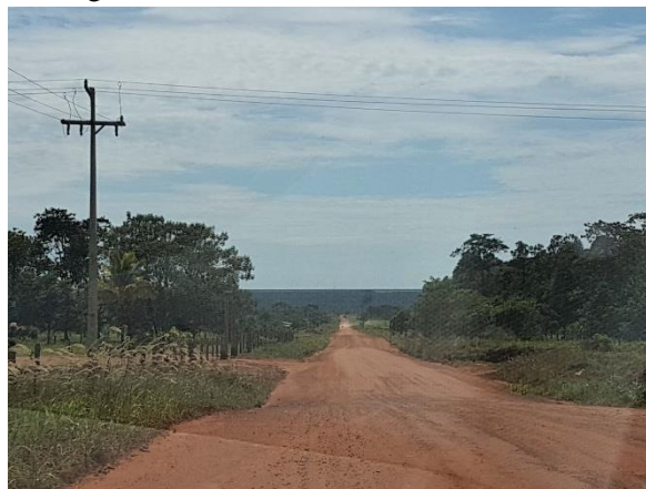
Figura 4. Vista da Estrada da Ponte Velha
