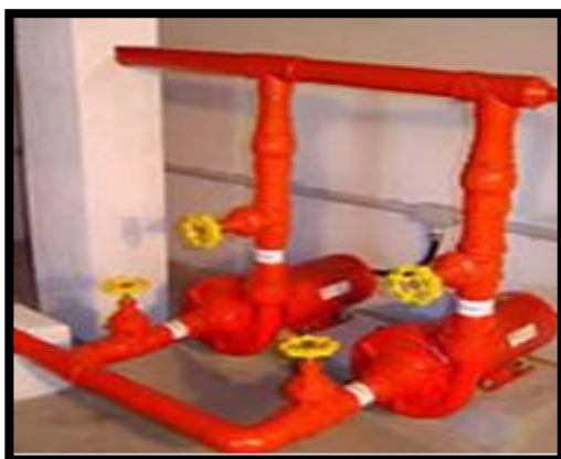
Figura 16 - Bomba de Incêndio
