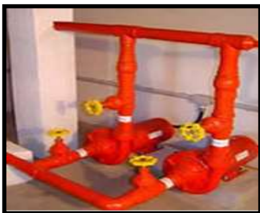
Figura 16 - Bomba de Incêndio
